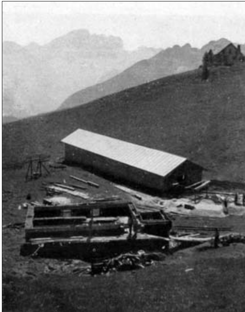
Malga "Losch" (Frassènè): sono in corso i lavori di costruzione dei fabbricati (in secondo piano il Rifugio Scarpa).
