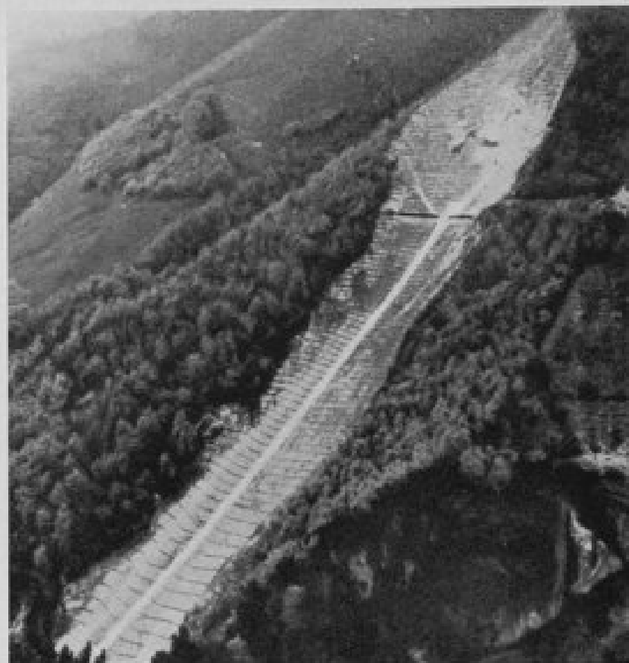
Foresta di Giunco; sistemazione di frana.
